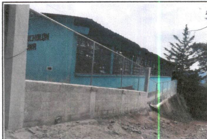
Foto 3: Finalizacion de un muro perimetral con maya y tuvo galvanizado.
