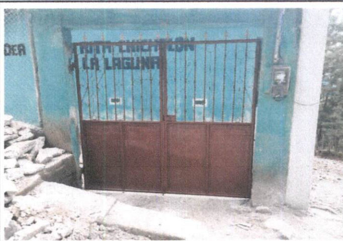
Foto 2 Finalizacion de la instalacion de un porton en el centro educativo.
